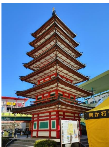
1/3 スケール七重塔
